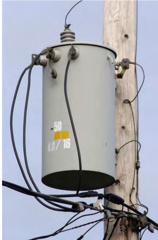
Figura 1. Los transformadores de potencia se utilizan a menudo en las líneas de distribución de energía.
